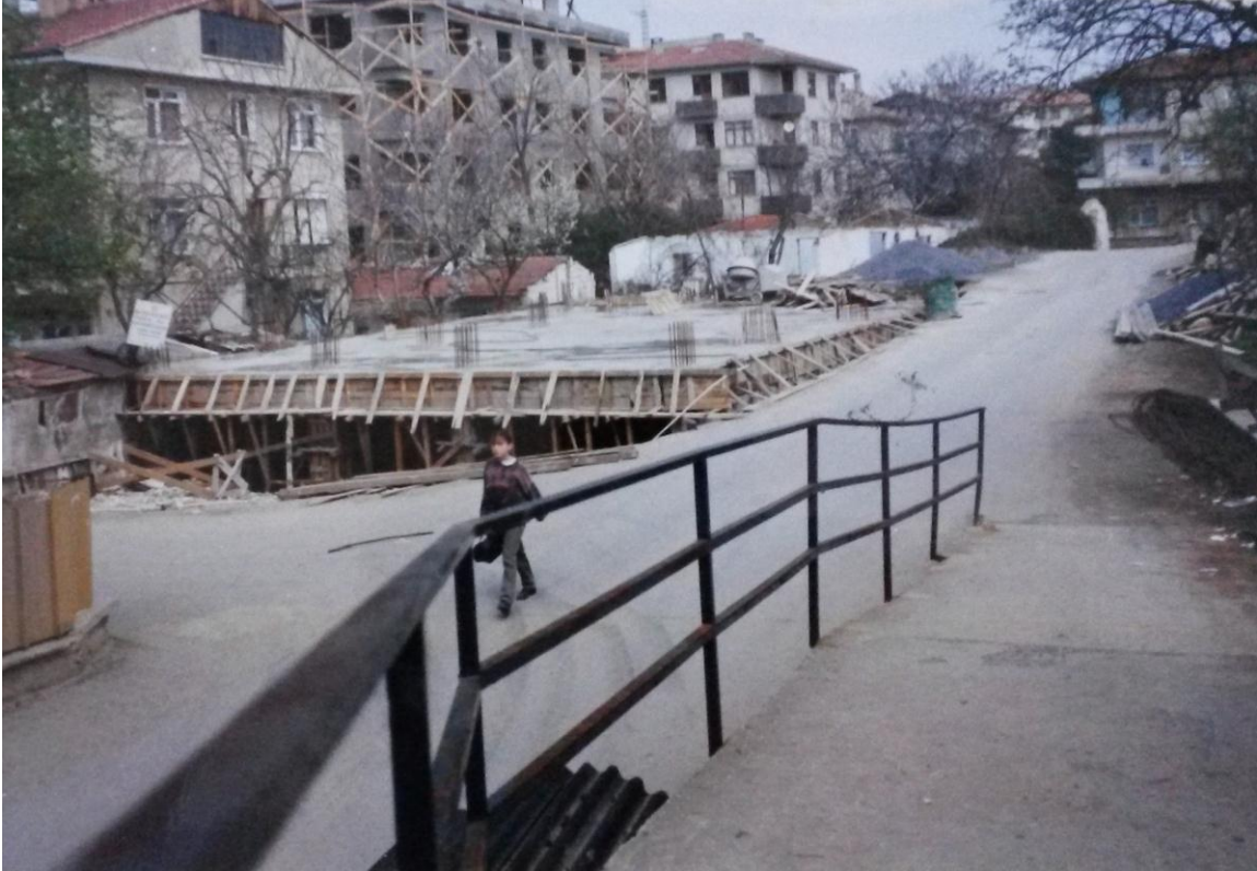
Fotoğraf 27: Yıkılan Kuran Kursu inşaat temeli - 1994 (Koruma Kurulu Arşivi)
