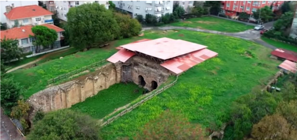
Fotoğraf 40: 2018 yılında çekilen hava fotoğrafında geçici çatı strüktürü (KYAP Arşivi, 2018)
