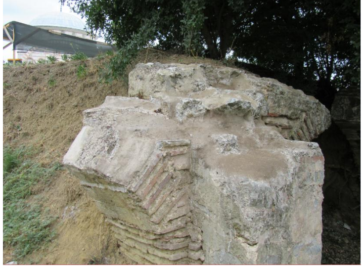
Fotoğraf 42: Kuzey-doğu duvarı üzerinde bulunan ayaklardan birinde koruma kaplaması öncesi ve sonrası görünüm (KYAP Arşivi, 2017)
