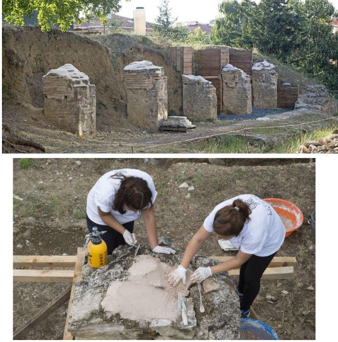
Fotoğraf 39: Küçükyalı kilise platform alanı kuzeydoğu cephesinde yapılan capping uygulaması (KYAP Arşivi, 2015)
