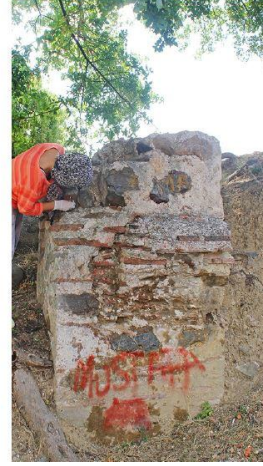
Fotoğraf 39: Küçükyalı kilise platform alanı kuzeydoğu cephesinde yapılan capping uygulaması (KYAP Arşivi, 2015)
